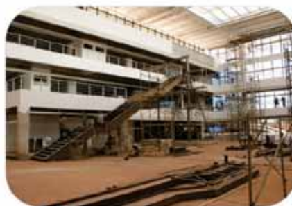
OBRA EM SUA FASE FINAL
