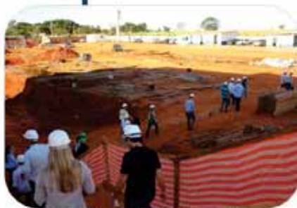
PRIMEIRA ETAPA DAS OBRAS DA NOVA SEDE
